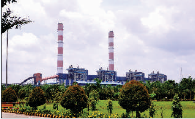
जिंदल पॉवर प्लांट
